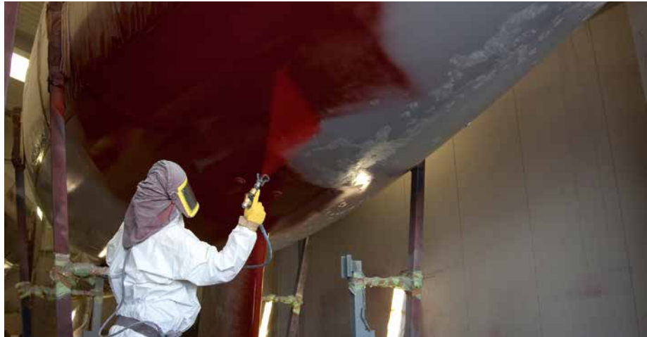
Epoxidbeschichtung in Airless-Spritztechnik
