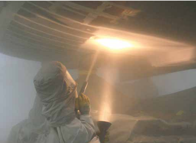
Nur der Sandstrahl erreicht tiefste Einfressungen
