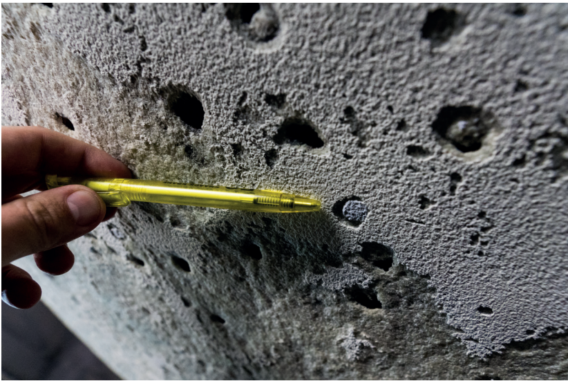
Die Oberfläche eines von Osmose befallenen Unterwasserschiffes nach dem kompletten Strahlen, die tiefen Nester wurden ausgebohrt.
