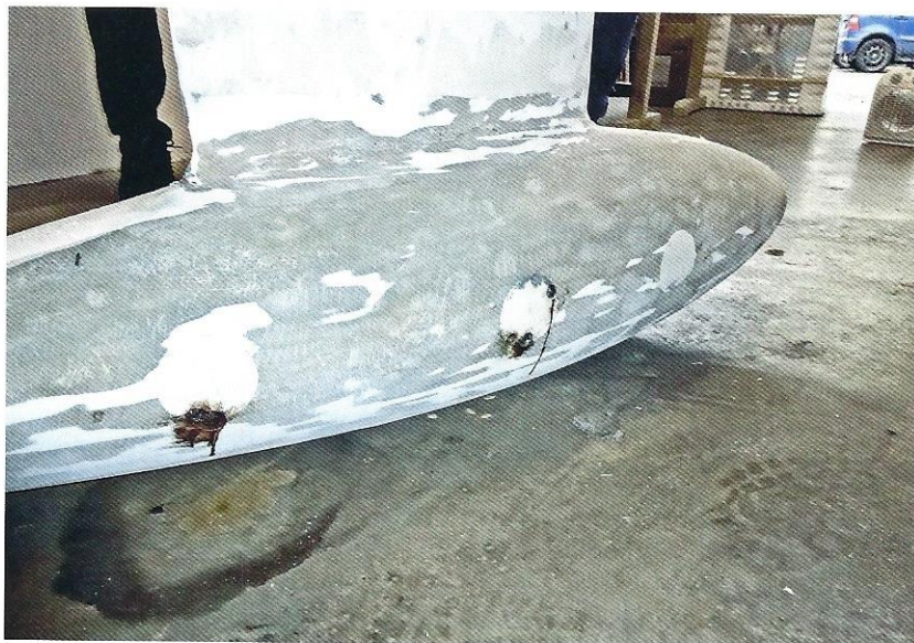
An dieser Eisenbombe frisst sich der Rost von innen nach außen.
