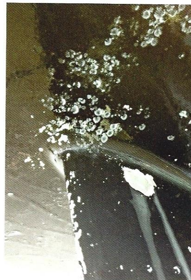
Abgeplatzte Farbschicht.
