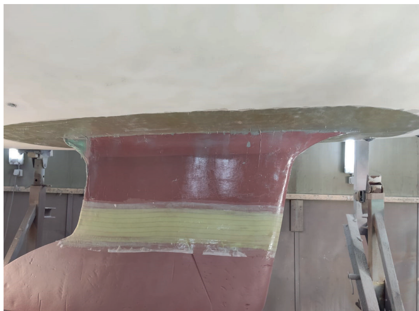
Statt einer Gummifuge erhält auch die Nahstelle dieses Kompositkiels ein Epoxid-Zusatzlaminat. Diese Lösung ist deutlich langlebiger und verhindert erneuten Wassereintritt zuverlässig.
