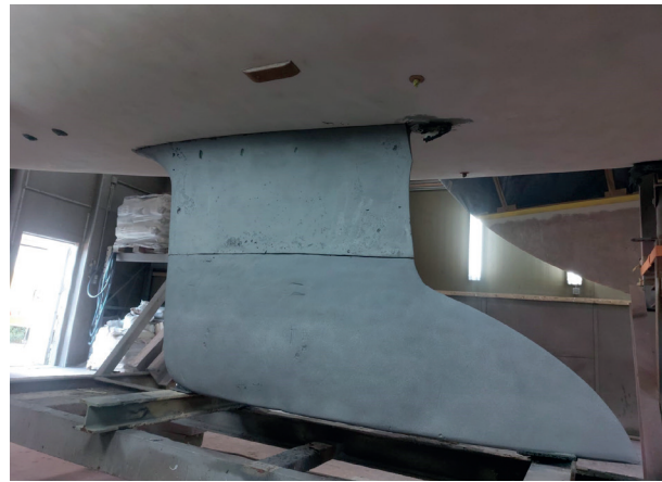
Der Kiel aus Gussstahl wird komplett sandgestrahlt, so werden auch tiefe Rostnester rückstandslos entfernt und es ergibt sich eine tragfähige Oberfläche.
