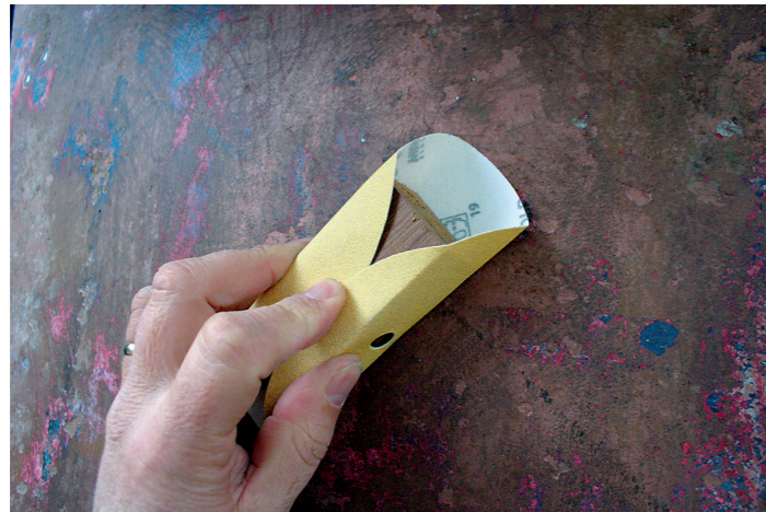
Das Entfernen von alte Schichten mit Sandpapier ist mühsam. Zum Anrauen der letzten Schicht aber ideal
