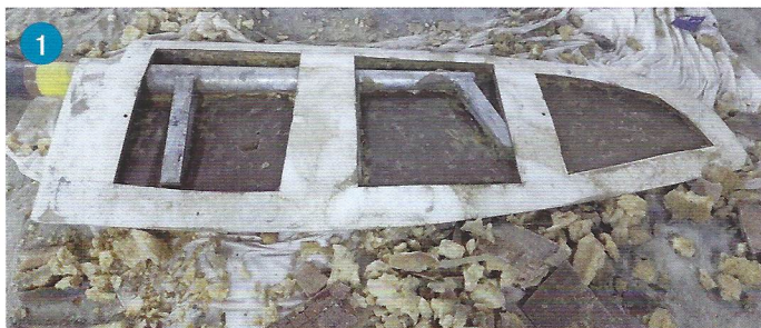
1. Mit Taschenschnitten wird das Ruderblatt einseitig geöffnet und das defekte Kernmaterial entfernt. Die Innenseite des ...
