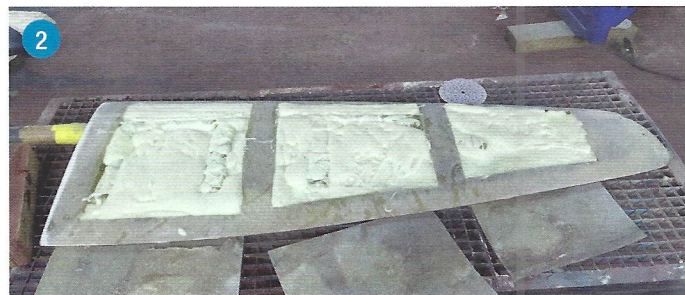
2. ... Ruderblattes wird sauber gestrahlt und bei 30°C getrocknet. Dann wird der Innenraum mit einem Epoxidschaum verfüllt.
